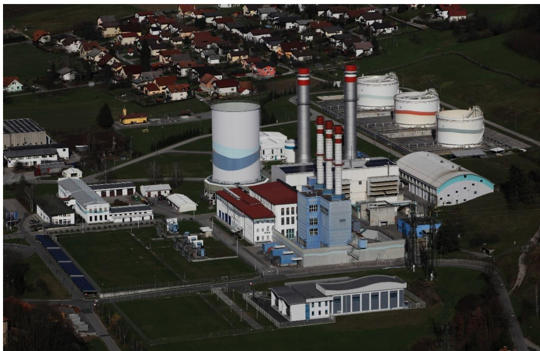
Na sliki: Plinska elektrarna Brestanica
