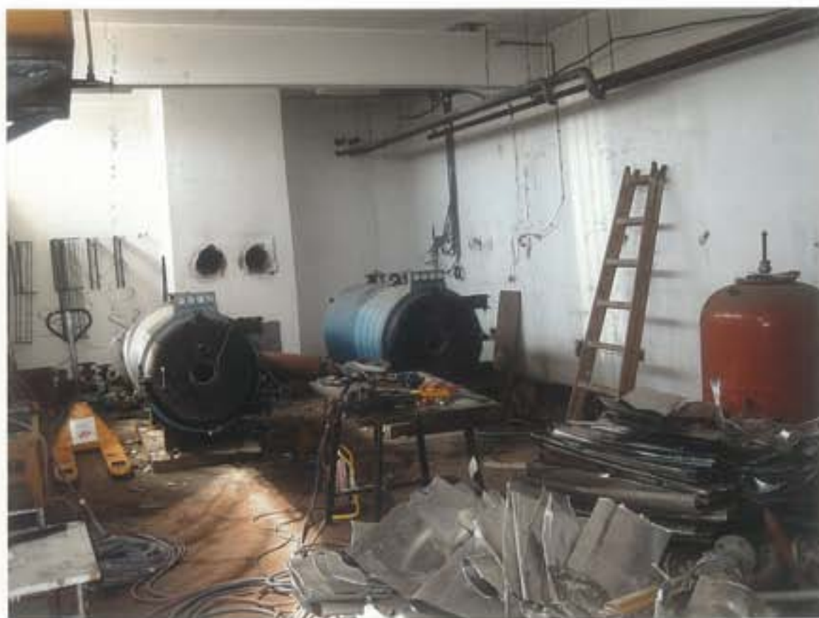
Zamjena dotrajalih kotlova i rezervoara
