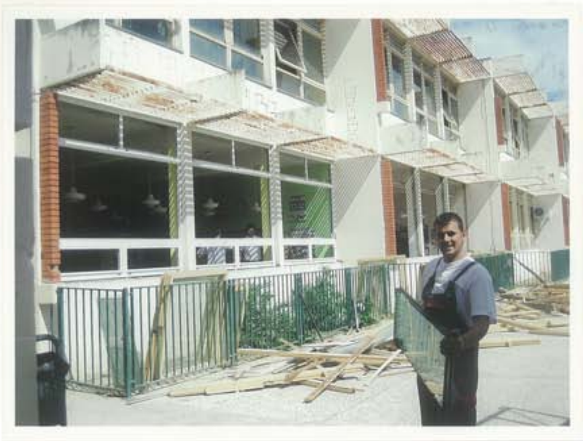
zamjena prozora na dijelu razv. nastave
