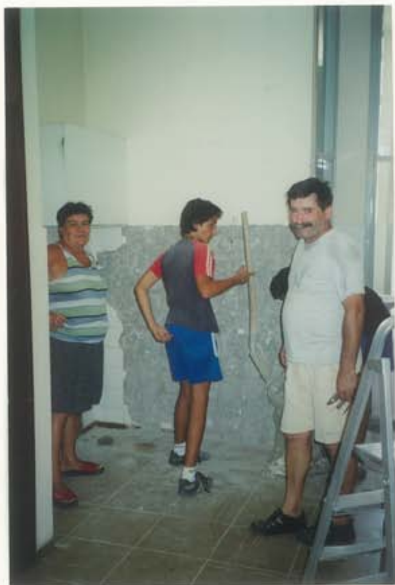
Sanacija čajne kuhinje
