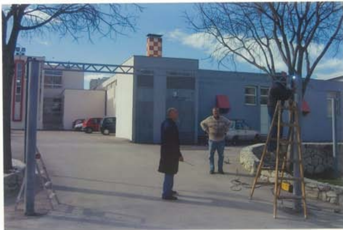
Postavljanje rampe na ulazu parkirališta
