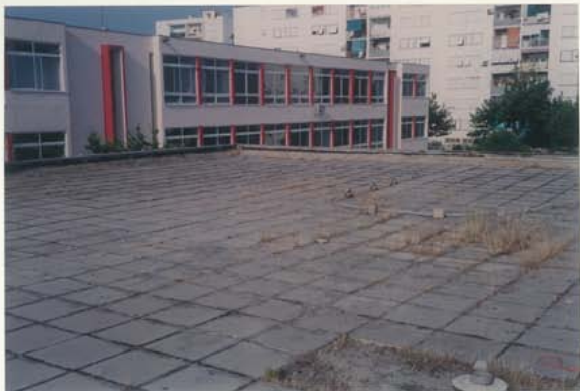
Dotulni krov zamijenjen je novim
