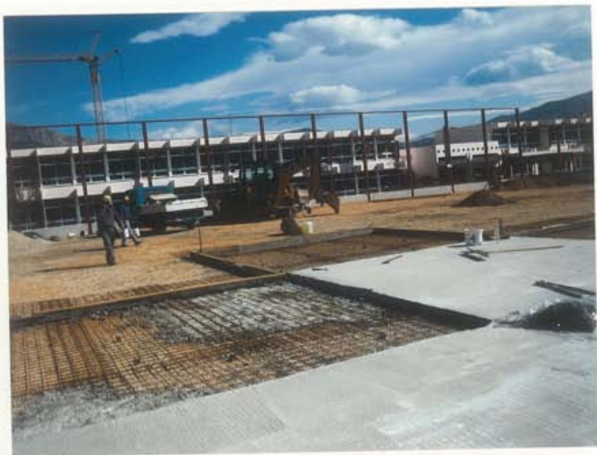
Radovi na novom igralištu
